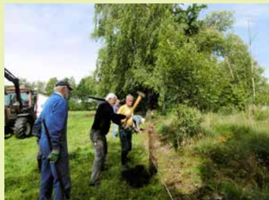
Zaunbau an der Enzian-Weide. Die alten Pfähle müssen raus (links). Die neuen Pfähle werden gesetzt mit Pfahlbohrer und Lehmann (rechts).
