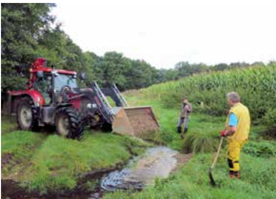
Kieseinbringung mit dem Frontlader und gezielte Verteilung durch fleißige Helfer
