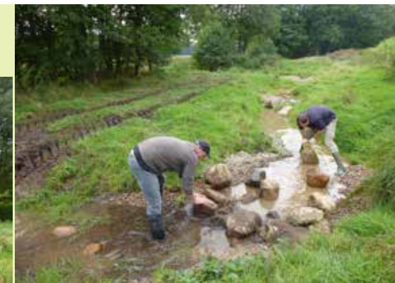
Auch die Steine und Findlinge werden mit Maschine und Muskelkraft gezielt arrangiert
