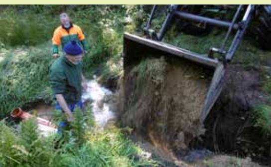
Links: An den Dittmer-Teichen: Das Verbindungsrohr mit Steuerungswinkel ist gelegt, der Damm zwischen den Teichen wird wieder geschlossen.
