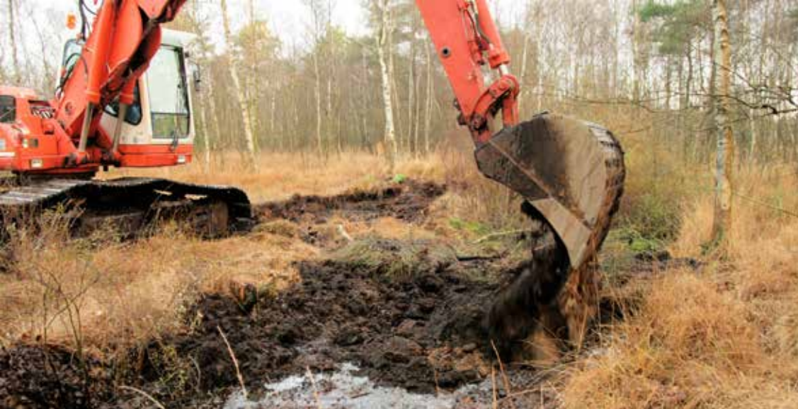
Entwässerungsgraben wird geschlossen
