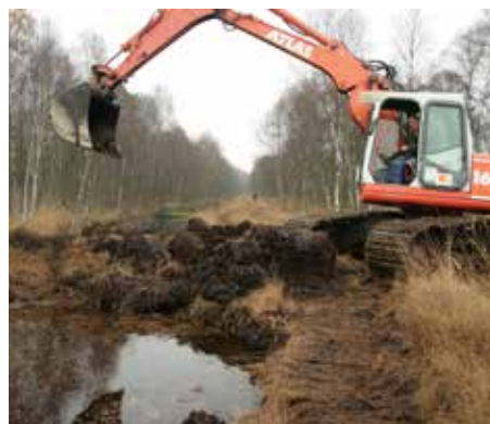
Oben: Der lange Diagonalvorfluter durch das Everstorfer Moor wird gekammert. Links: Gekonnt, fast „zart“ streift die Unterkante der Schaufel glättend an der Steilwand herab.
