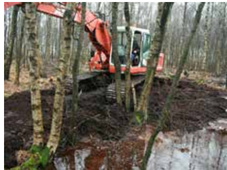
Links: Schwieriges Gelände im Everstorfer Moor beim Wechsel zum nächsten Einsatzort. Oben: Letzter Damm auf weichem Untergrund. Der Damm muss den 20-Tonner tragen.
