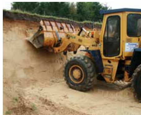
Oben: Der lange Diagonalvorfluter durch das Everstorfer Moor wird gekammert. Links: Gekonnt, fast „zart“ streift die Unterkante der Schaufel glättend an der Steilwand herab.
