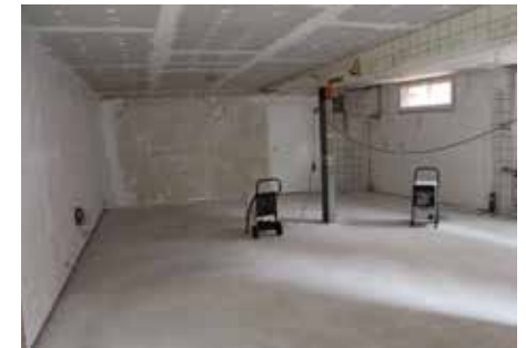
Neu gebaut: Ein bequemer Weg nach oben. Der Untergrund für den Linoleumbelag ist vorbereitet (vgl. Foto S. 68).
