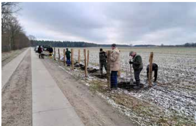
Aufbau eines Wildschutzzaunes an der Weller Moorstraße zum Schutz der Pflanzungen am dortigen Wegrand.
