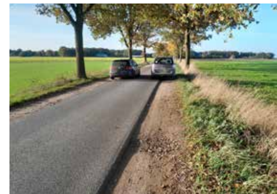
Das Foto zeigt, dass für Begegnungsverkehr auf 3 m breiten Straßen, ein beidseitiger Streifen von max. 1,2 m ausreicht, um die Verkehrssicherheit zu gewährleisten. Im Einzelfall kann es erforderlich sein, dass Fahrzeuge mit Überbreite durch rücksichtsvolles Verhalten einen Begegnungsverkehr ermöglichen müssen.
