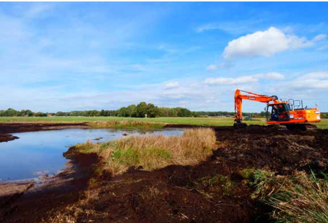
Der Bagger beim Abflachen der Ufer am Wiesentümpel Nr. 13. Gut zu erkennen ist, dass sich an dieser Stelle ursprünglich Moor befunden hat. Der Aushub besteht oben aus Torf, darunter befindet sich Sand. Dieser wird flach in der Umgebung verteilt.
