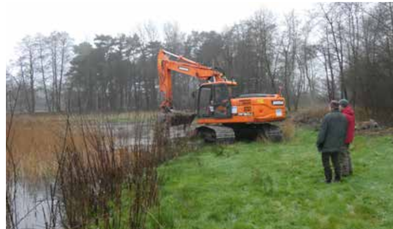
Die Ufer werden abgezogen, die Gehölze entfernt und das Schilf in seiner Ausdehnung verringert.
