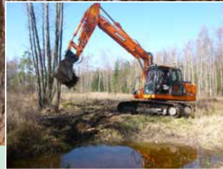
Der Bagger bei der Verstärkung einer Grabenkammerung im Knickwald. Dabei entstehen zahlreiche wertvolle kleine Tümpel (großes Bild).
