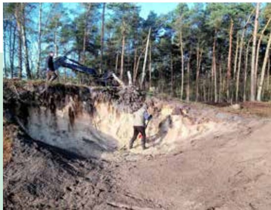
Die Reste einer kleinen Sandwand sind freigelegt und werden nach dem Baggereinsatz per Hand „schön“ gemacht.
