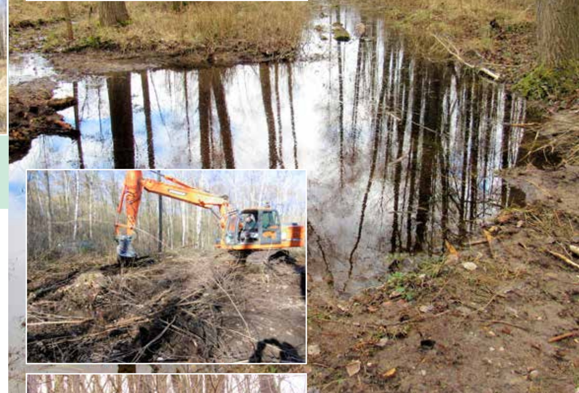
Der erstrebte Rückstau des Wassers ermöglicht bei guten Niederschlägen die Vernässung der Seitenräume, z. B. im Erlenbruch (großes Bild). Zusätzliche Erweiterung eines in 2020 durch Stau erzielten Tümpels (oben). Der Bagger beim Traubenkirschenreißen: es entsteht zunächst ein wildes Chaos. Nacharbeiten durch die RB: Abschütteln des Bodens vom Wurzelstock und Endlagerung zur Vermeidung von Stockausschlag und neuer Wurzelbildung.
